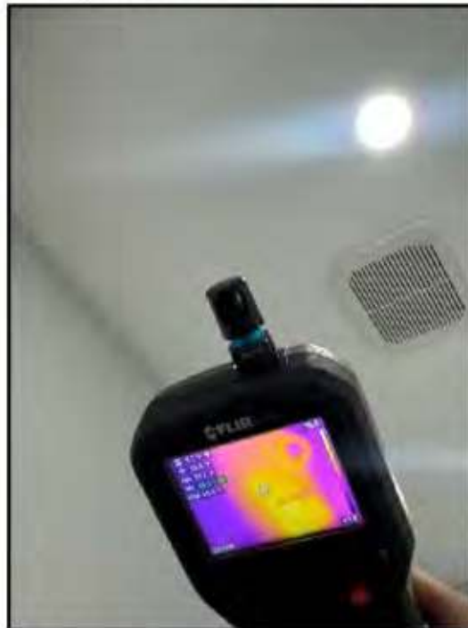
148. Gaps or voids
